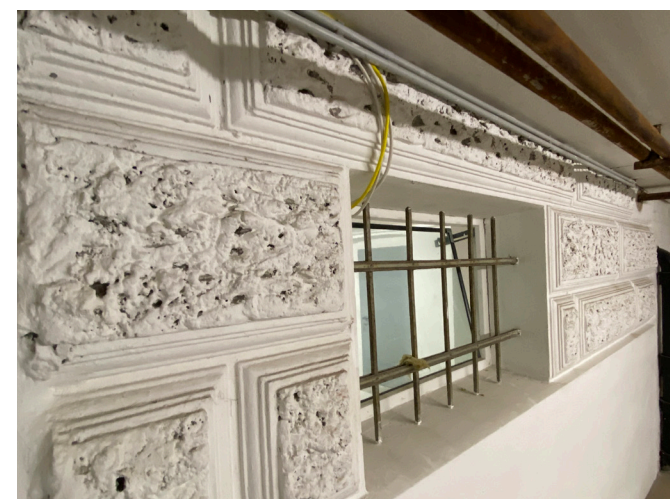
Im Keller des östlichen Anbaus ist der Sockel des Hauses aus dem Jahr 1860/70 anschaulich zu sehen.
