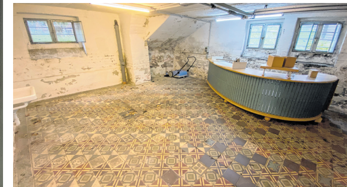
... und wurden in der Tiefgarage im westlichen Anbau auf der Erde verlegt.
