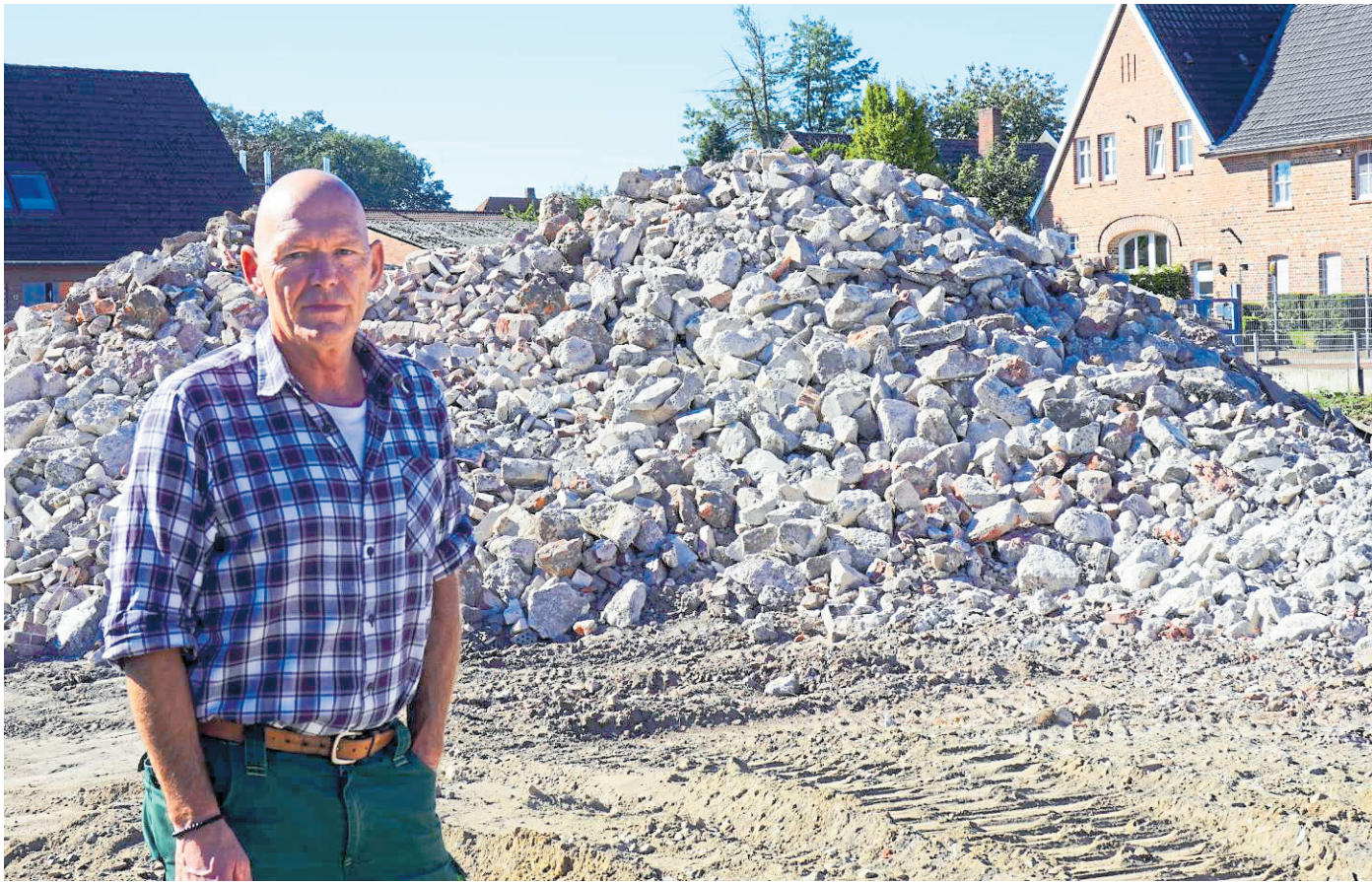
Von dem löchrigen Bestandsgebäude, das an der Gustav-Böcker-Straße zwischenzeitlich als Dohlen-Hotel diente, ist nicht mehr viel übrig. Stattdessen werden die Arbeiten im Holtwicker Ortskern inzwischen fortgesetzt, wie Investor Martin Dreinemann informiert.
